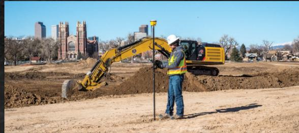
Il **Sistema di Posizionamento Trimble Siteworks per i topografi di cantiere** è comprensivo di GNSS Smart Antenna SPS986 o SPS785, il controller TSC7 o il tablet T7 e il Software Siteworks. Consente ai topografi di cantiere di gestire e visualizzare complessi modelli tridimensionali, raccogliere molto più rapidamente ampi set di dati e lavorare in modo efficiente sia durante il giorno che durante la notte.
